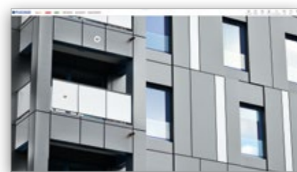
Balkóny a zábradlí
