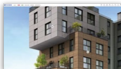
Immeuble à plusieurs étages
